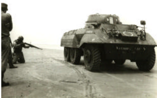
Testes com pneus P.P.B. num M-8. Notar o tiro de fuzil, após, o pneu é reparado por um técnico da Novatração. Crédito das fotos: Coleção autor
