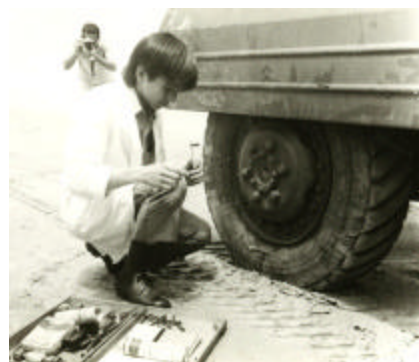
Testes com pneus P.P.B. num M-8. Notar o tiro de fuzil, após, o pneu é reparado por um técnico da Novatração. Crédito das fotos: Coleção autor
