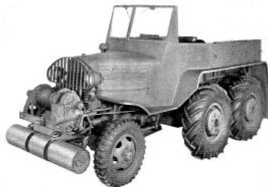
Trator MINNEAPOLIS MOLINE GTX-147 6x6. Notar o guincho e o para choque móvel. Foto: coleção autor
