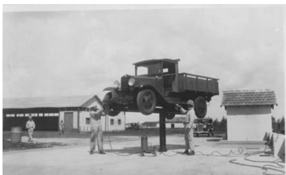
SCT – Manutenção em elevador hidráulico de um Chevrolet e seção de carpintaria onde construíam as cabines e carrocerias. (Fotos: Coleção autor)
