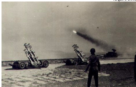
Lançadores de foguetes F-114-DE com cinco foguetes, montados sobre reparos Bofors 40/60. Notar o lançamento de um foguete Fv-108-R na foto da direita.
