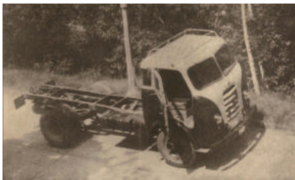
Detalhe da cabina e chassi do FNM D-11000, tanto para a versão civil como para a militar, as diferenças são mínimas. Crédito da foto: Arquivo FNM
